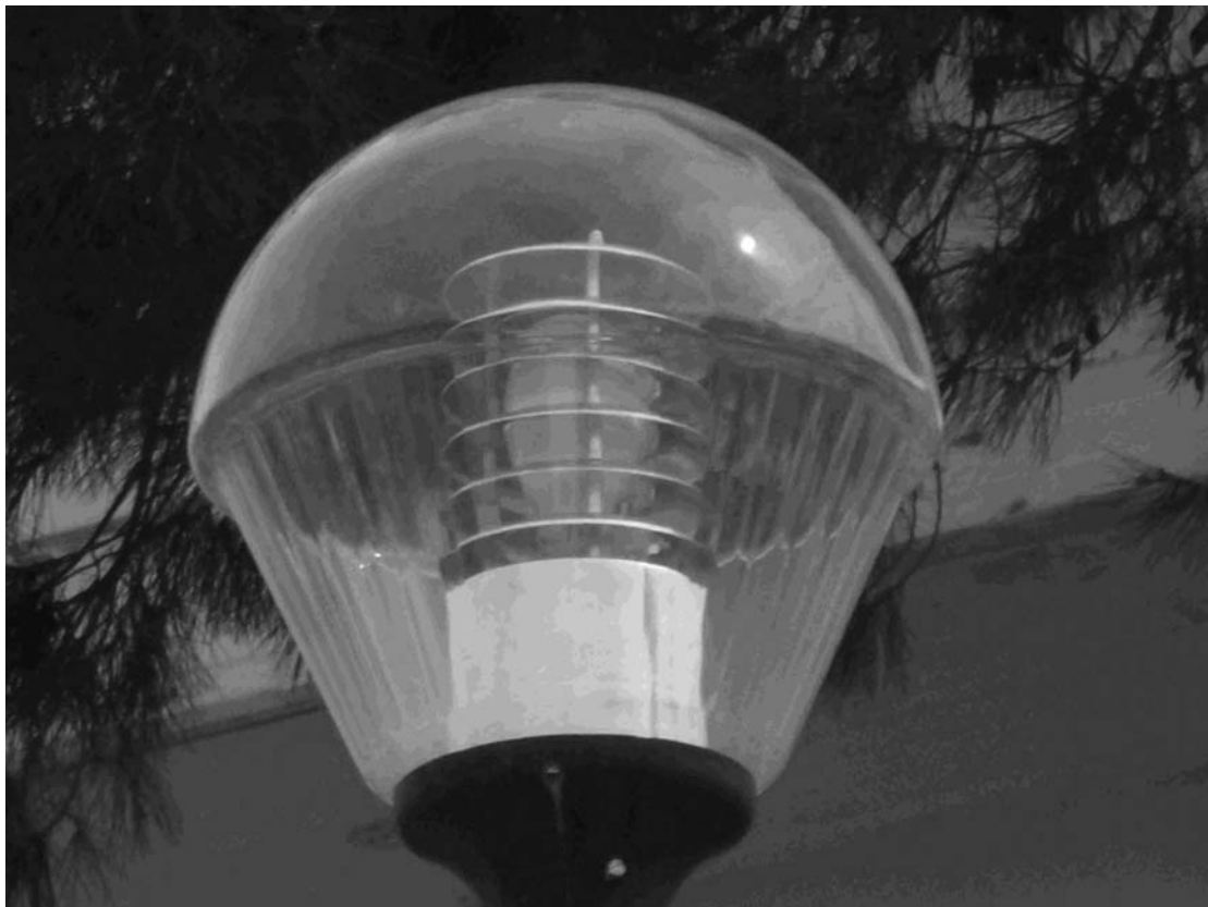
Φωτογραφία 1. Δ.Ε. Ροδόπολης: Διαφανές φωτιστικό μπάλας Φ400 Hg 125W με γρίφα αλουμινίου, πλήρες.
