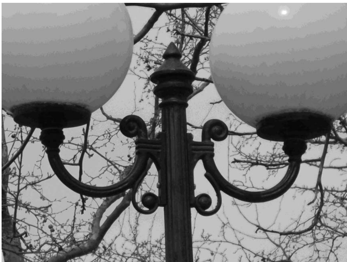
Φωτογραφία 5. Οδοί Πιπεροπούλου και Μεγάλου Αλεξάνδρου στη Δ.Ε. Σταμάτας: Ιστός 5 τεμαχίων, με δγωνα βάση, δίφωτος με φωτιστικά μπάλας Φ400 Hg 125W, κομπλέ.
