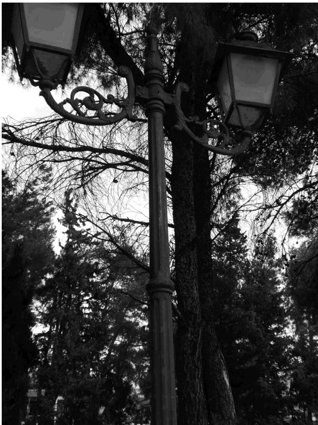
Φωτογραφία 9. Ηρώων Πολυτεχνείου Δ.Ε. Αγίου Στεφάνου: Μπράτσο και φωτιστικό φανάρι Na 70W.
