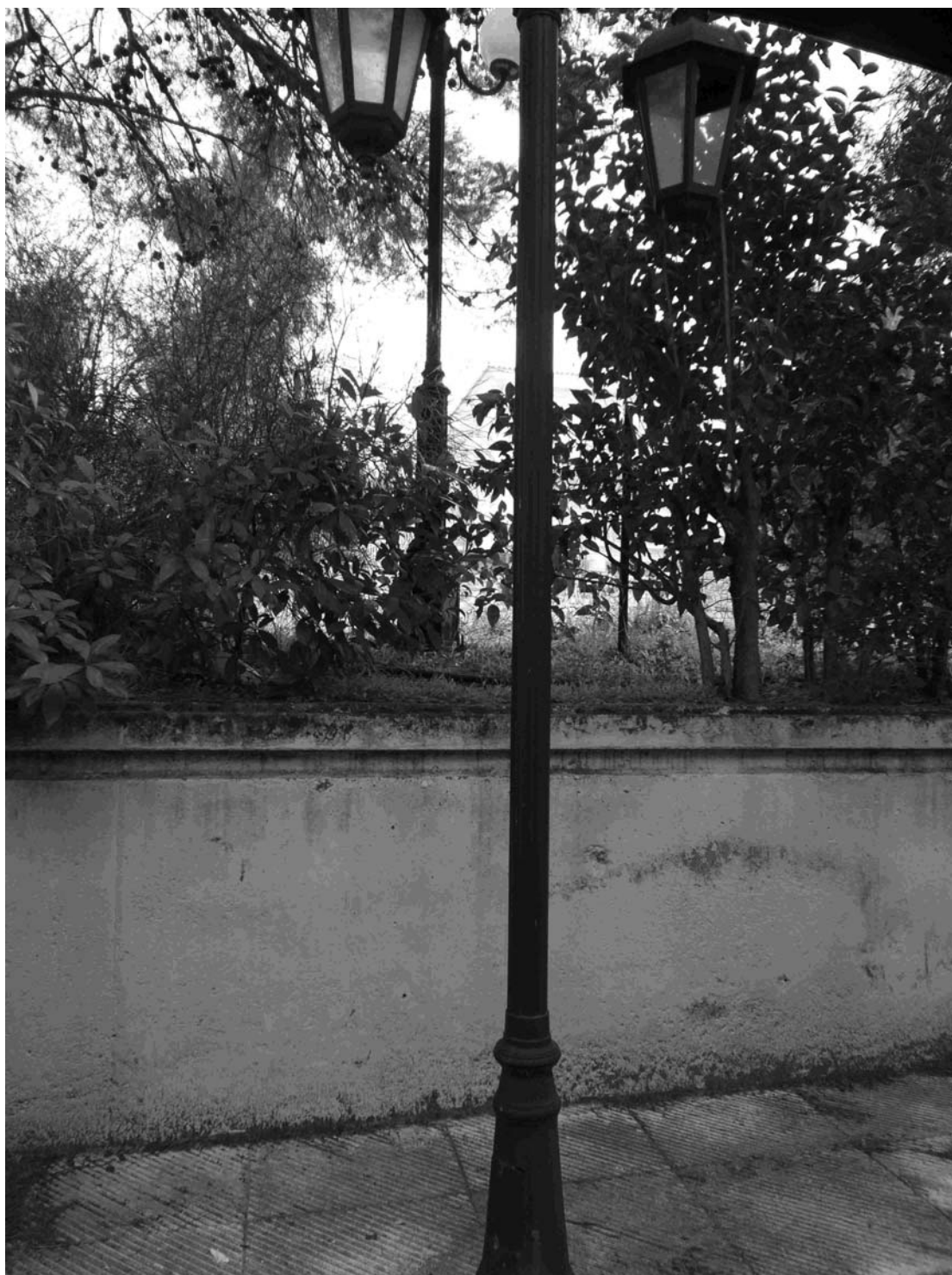
Φωτογραφία 11. Πλατεία Τριανταφυλλιάς Δ.Ε. Άνοιξης: Ιστός με βάση κουλουρουκωνικού τύπου, δίδωτη με φανάρια εξάγωνα, κομπλέ.
