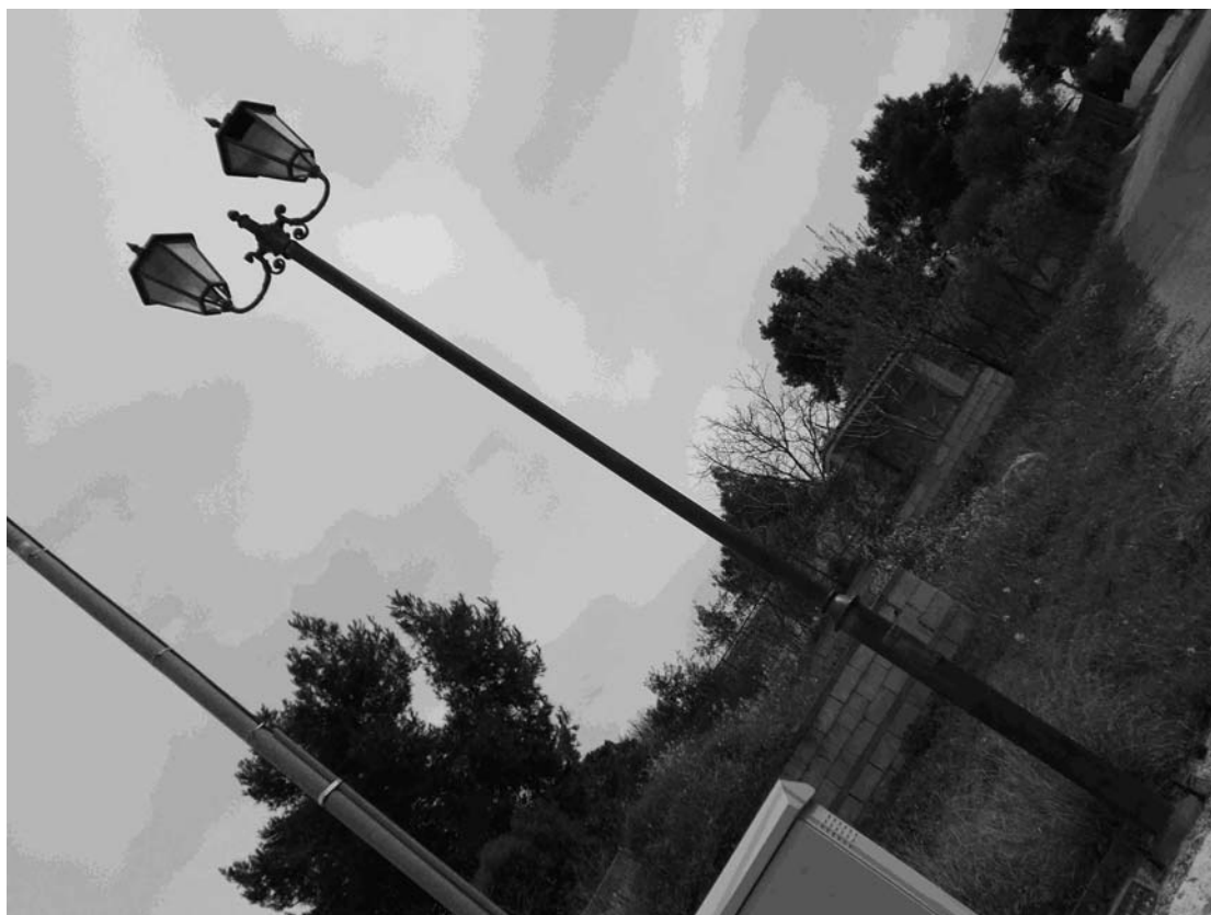
Φωτογραφία 7. Πλατεία Ανθέων Δ.Ε. Σταμάτας: Ιστός με διπλή κεφαλή και δγωνα φαναράκια.
