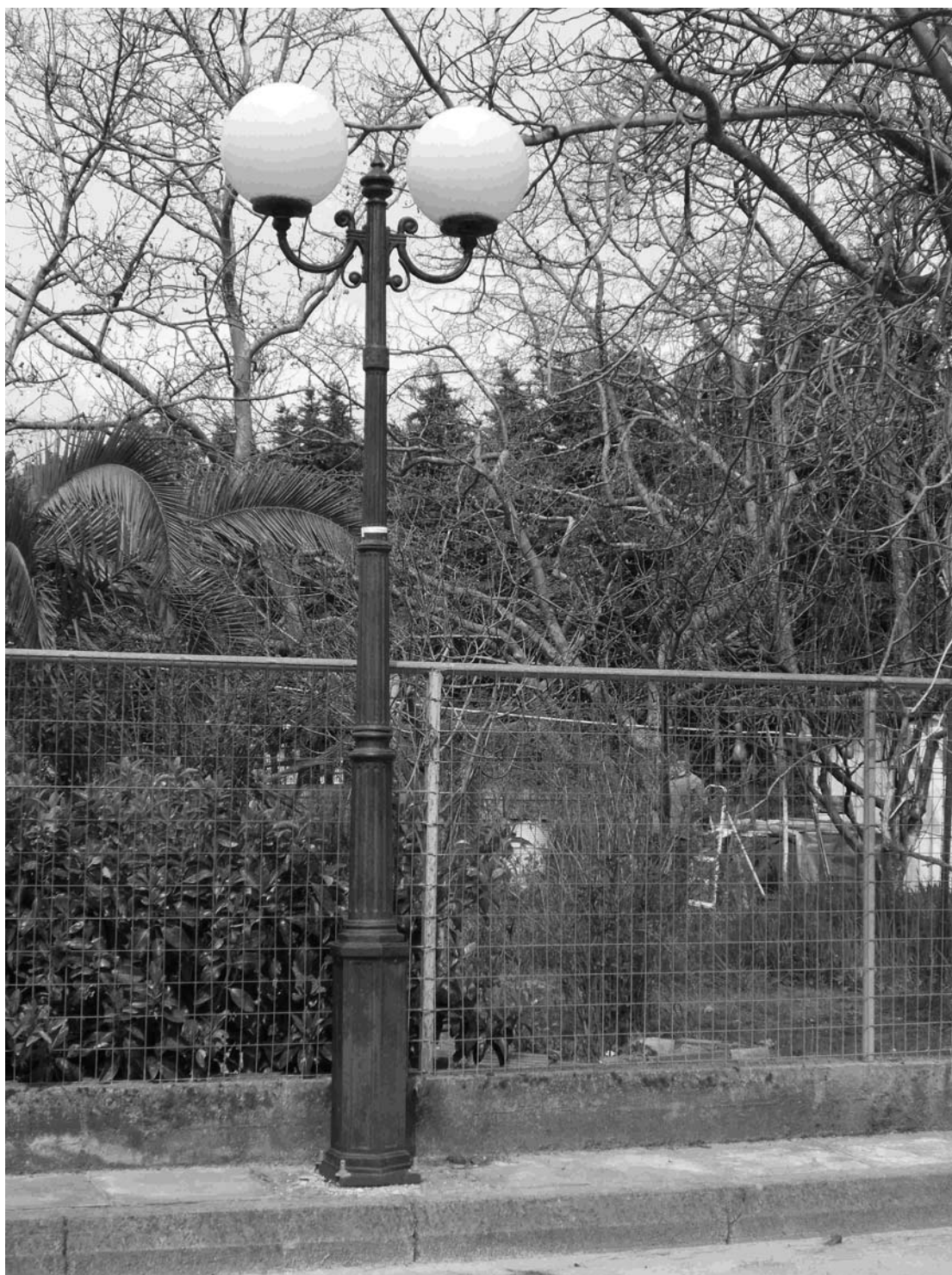
Φωτογραφία 2. Οδοί Πιπεροπούλου και Μεγάλου Αλεξάνδρου στη Δ.Ε. Σταμάτας: Ιστός 5 τεμαχίων, με δγωνα βάση, δίφωτος με φωτιστικά μπάλας Φ400 Hg 125W, κομπλέ.
